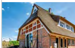
Sanierung und Umbau
